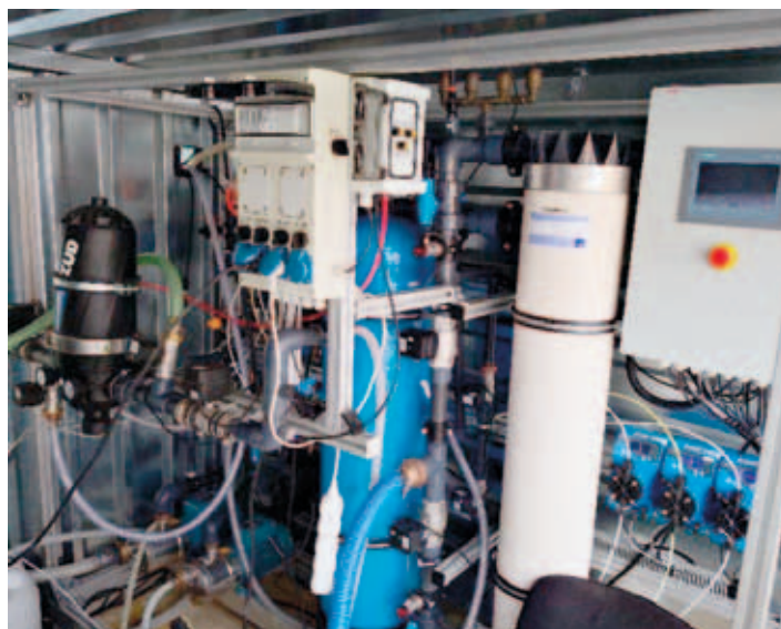
Testování UF v prádelenském provozu
