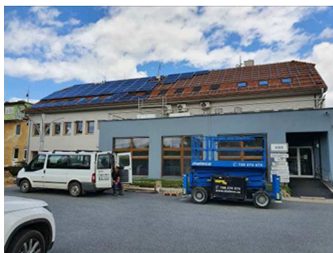
Obr. Instalace fotovoltaiky na administrativní budově
