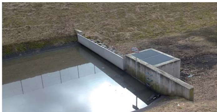
Normová stěna OLK – havarijní zabezpečení a předčištění před zásakem
