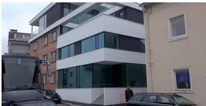
Dům v pasivním standardu na Bernardingasse (Wells)
