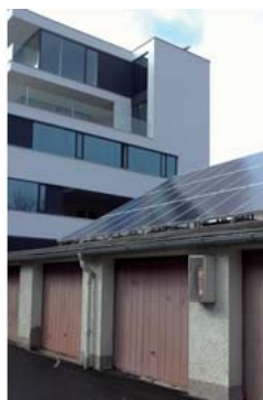
Fotovoltaika jako zdroj energie (+palivové články na akumulaci proud) a detail odvádění srážkové vody do zásaku.
