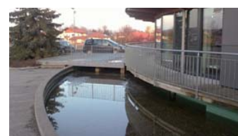
Další způsob jak se vypořádat se srážkovými vodami – kombinace odpar a zásak a estetický efekt
