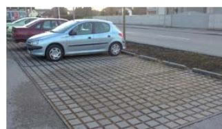
Nejrůznější provedení HDV – odvedení z plochy a zásak v průlehu, kombinace povrchů parkoviště
