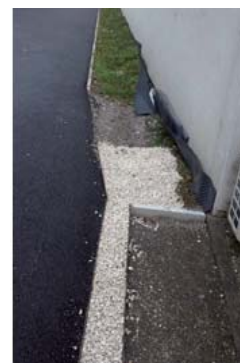
Fotovoltaika jako zdroj energie (+palivové články na akumulaci proud) a detail odvádění srážkové vody do zásaku.
