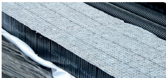
Zasakovací tunely umístěné mezi bloky AS-NIDAFLOW
