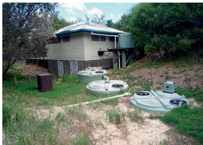
ČOV není moc vidět, ale když jsou, tak končí zásakem
