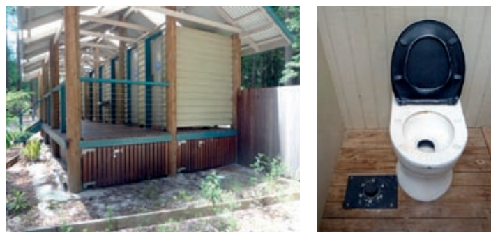
Suché záchody na exponovaných místech – speciální konstrukce s minimální spotřebou vody
