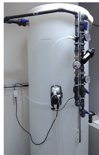
Vstup do reakčních a akumulárních nádrží
