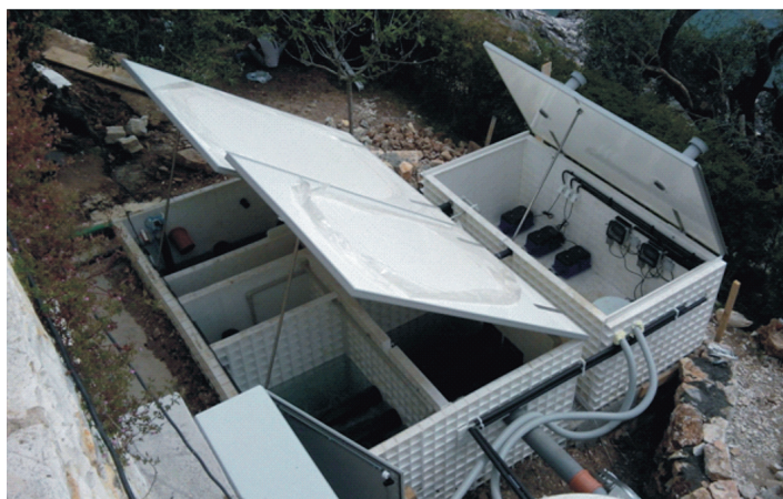
Obr. 1 – Pohled na čistírnu SBR
