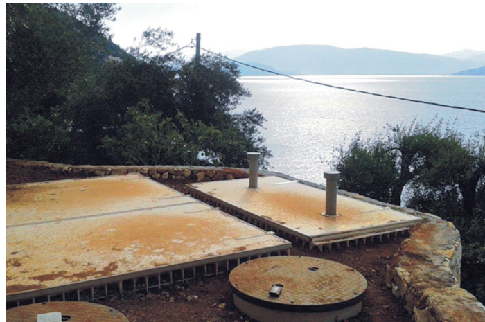
Obr. 2 – Pohled na čistírnu SBR
