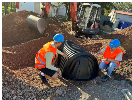
Zasypání tunelových prvků
