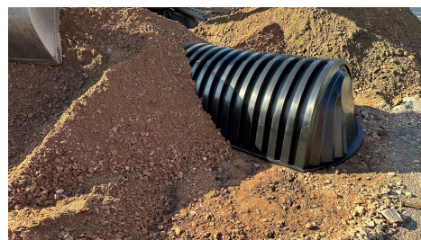
Tunel AS-KRECHT OPTIMAL ve stavebním výkopu
