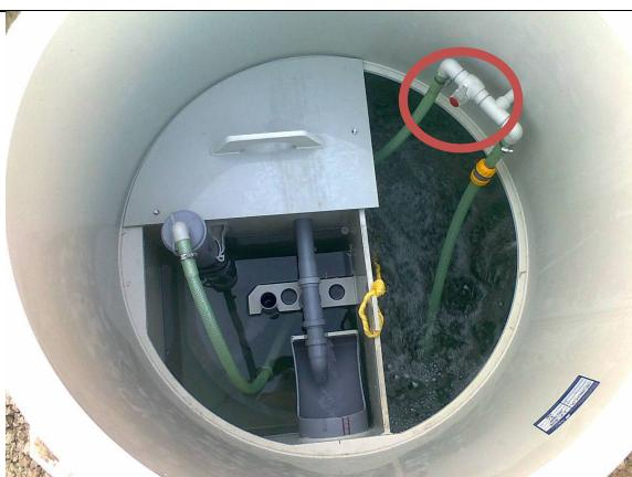
**Zapojte dmychadlo do zásuvky.** Dmychadlo se rozjede a bude vydávat tichý vrnivý zvuk. Zkontrolujte, zdali neuniká vzduch v okolí připojení k dmychadlu nebo ČOV, případně dotáhněte a utěsněte spoje.
