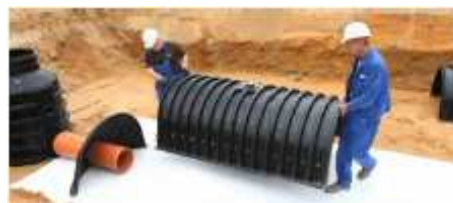
Připojení přítokového potrubí
