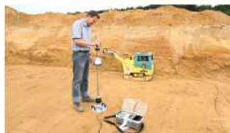
Tlaková zkouška desky v podloží
