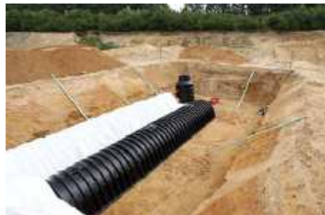
Položení geotextilie
