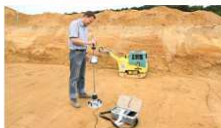
Tlaková zkouška desky v podloží
