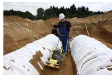
Zhutňování malou vibrační deskou mezi řadami tunelů
