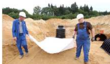
Geotextilie v nátokovém prostoru
