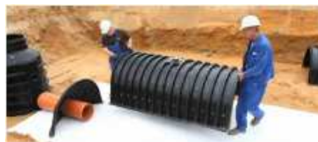
Připojení přítokového potrubí
