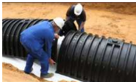
Spojení středových částí
