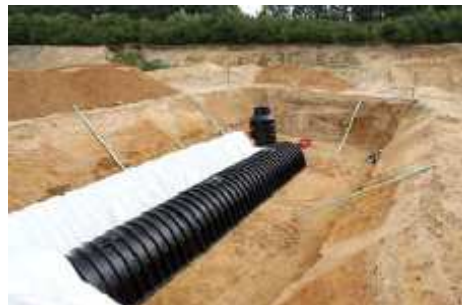
Položení geotextilie
