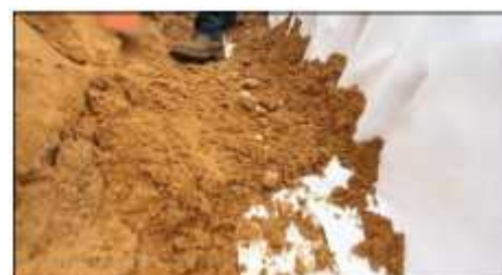
Udusání geotextilie pro upevnění
