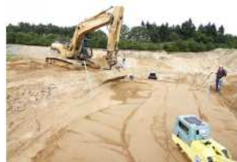
Překrytí tunelového systému
