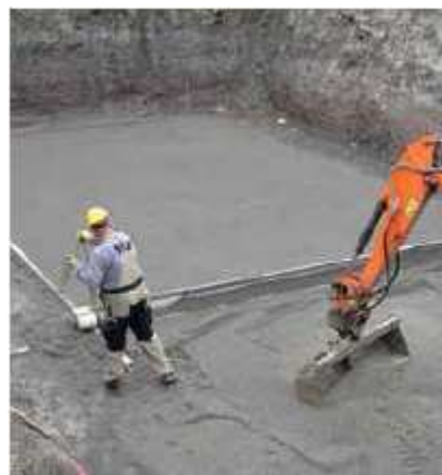
Obrázek č. 8: Příprava podkladu stavební jámy
