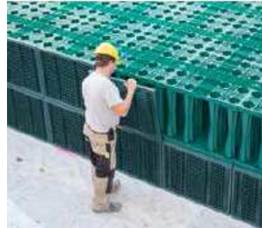
Obrázek č. 17: Montáž bočních mřížek
