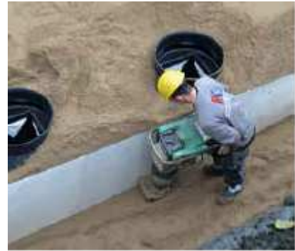
Obrázek č. 19: Hutnění bočního zásypu
