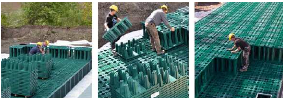
Obrázek č. 13: Předmontáž bloků AS-RIGOFILL ve stavební jámě
