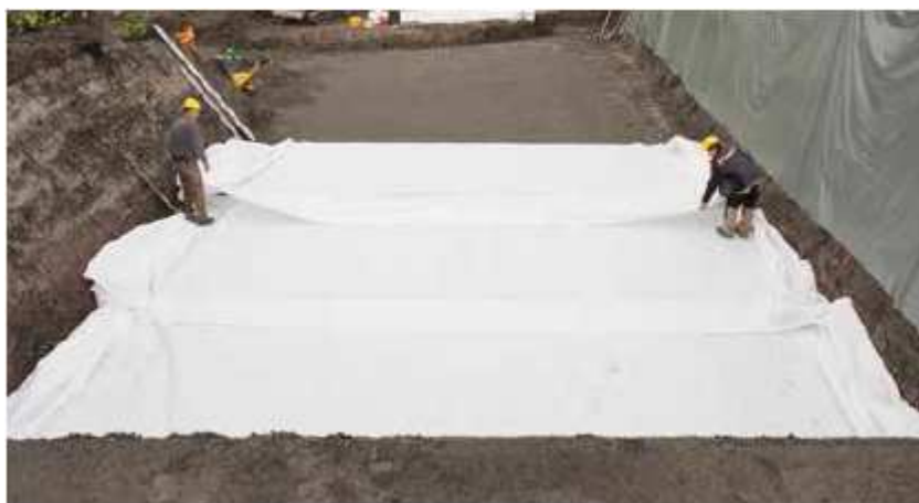
Obrázek č. 9: Pokládka geotextilie
