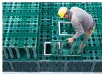
Obrázek č. 14: Zabudování šachet AS-QuadroControl
