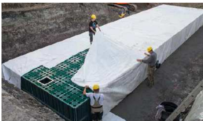
Obrázek č. 18: Obalení geotextilií AS-RigoFlor
