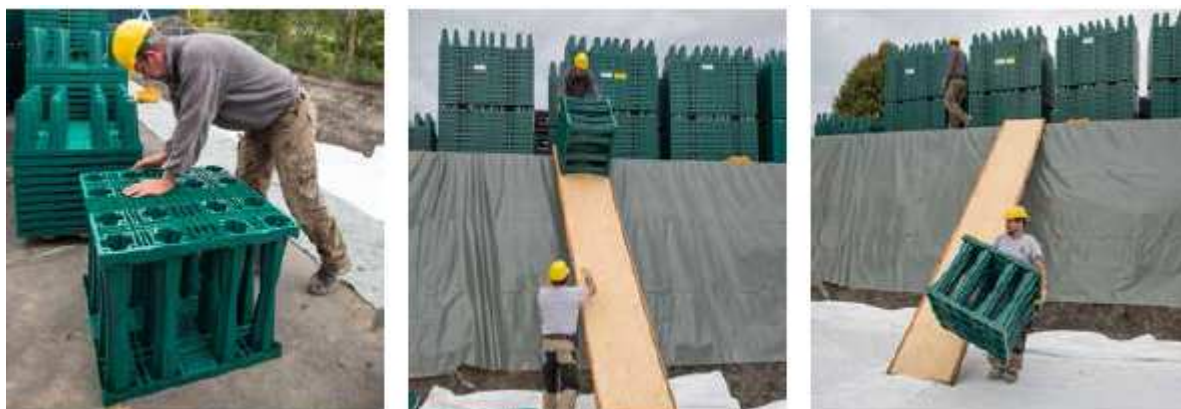
Obrázek č. 12: Předmontáž bloků AS-RIGOFILL mimo stavební jámu
