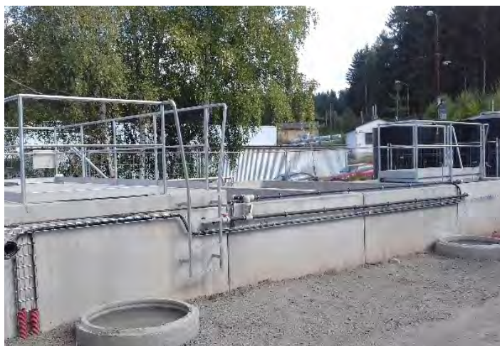
Chemické předúprava OV pomocí míchaných reaktorů
