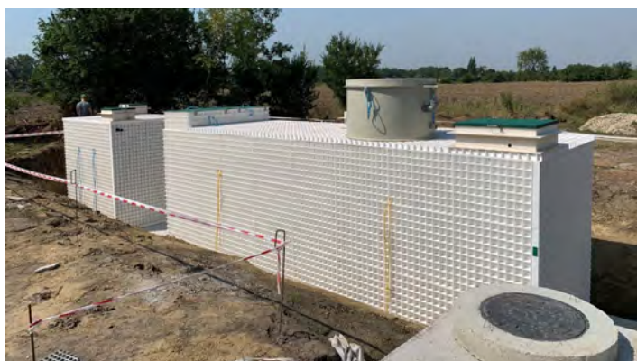
Umístění plastových nádrží do násypu bez nutnosti obetonování
