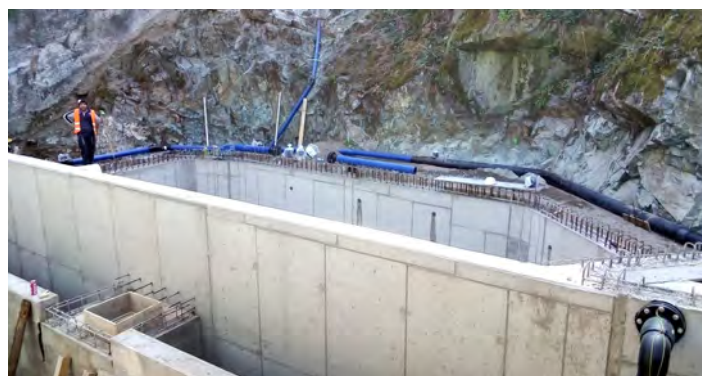
Příprava monolitické konstrukce bazénu
