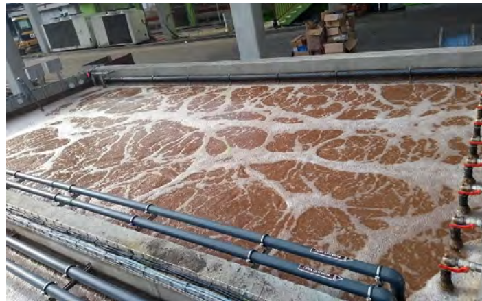
Technologie biologické dočištění průmyslových odpadních vod
