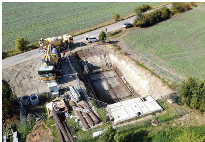
Hloubení stavební jámy
