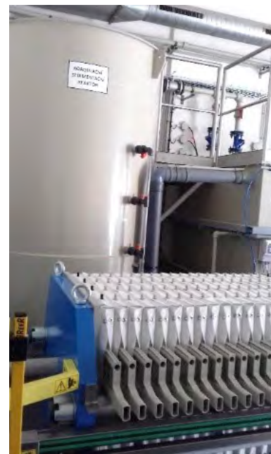
Sedimentační reaktor včetně kalolisu
