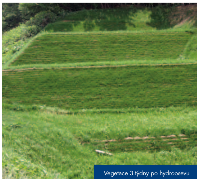
Hydroseov (hydroseeding) vegetačních pytlů AS-GREEN SLOPE
