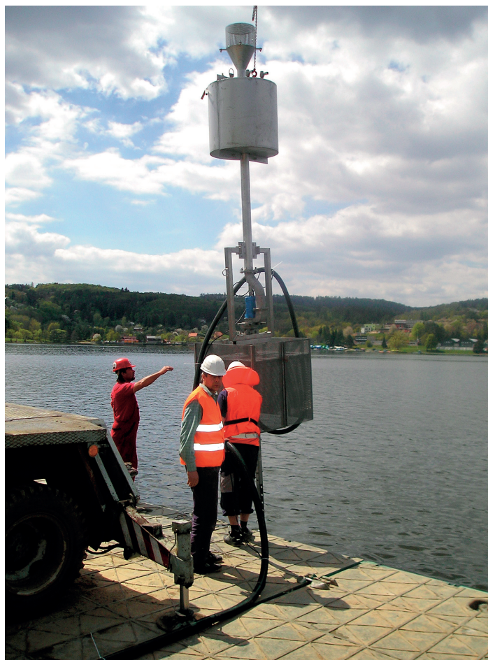
Instalace aeračních věží pod hladinu jezera
