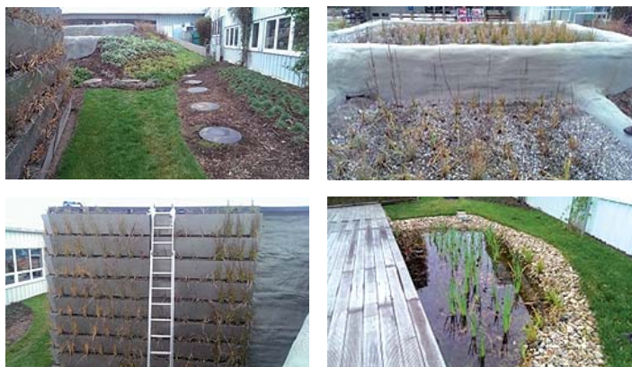
Jednotlivé části čistírny
