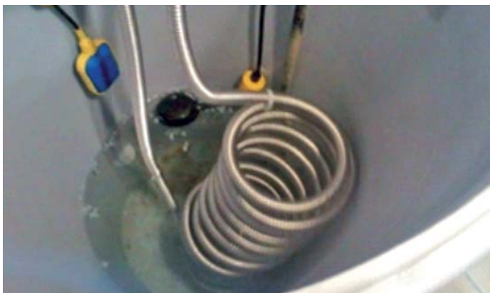
Obr. 2: Tepelný výměník v nádržích AS-GW/AQUALOOP
