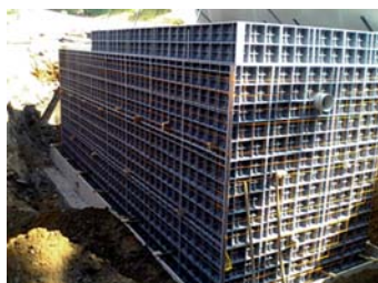
ČOV Vojslavice – osazení, armování
