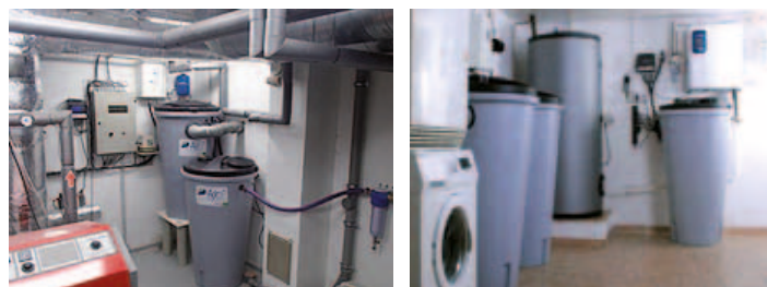
Obr. 2: vlevo systém na čištění šedých vod ve vzdělávacím centru (Rozmarýnek, Brno) a v rodinném domě (Kelmis, Belgie)
