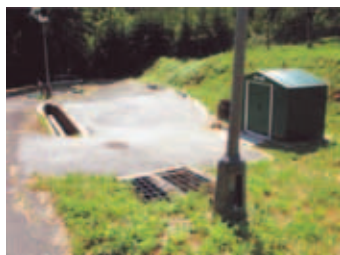
Původní čistírna odpadních vod Vojslavice
