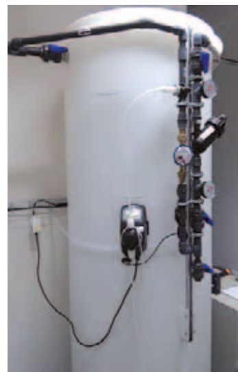
Vstup do reakčních a akumulárních nádrží
