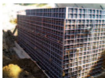
ČOV Vojslavice - osazení, armování
