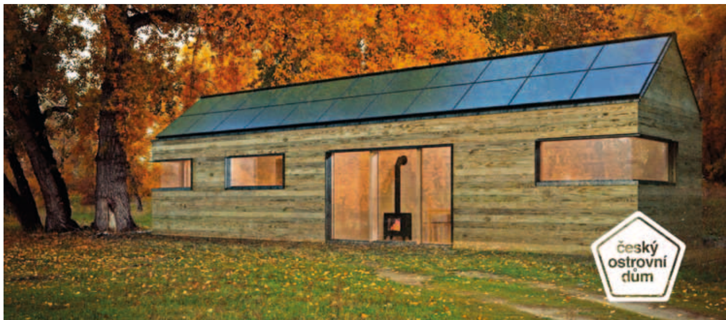
Obr. 1: Jeden z vítězných návrhů v projektu „Český ostrovní dům“, (zdroj: http://www.ceskyostrovnidum.cz/stavby.html )
