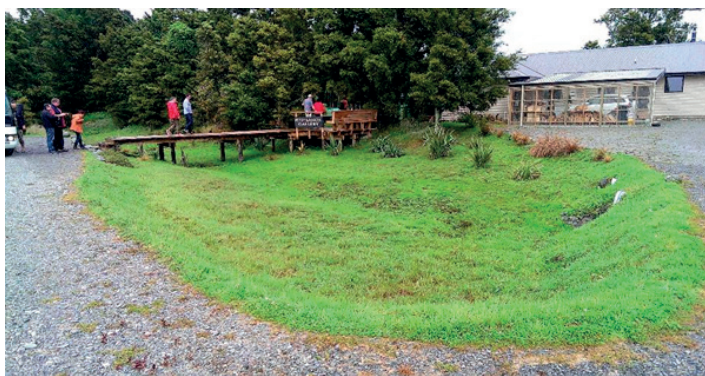
Obr. 2 Povrchová vsakovací nádrž
