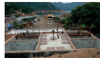
ČOV v průběhu stavby
