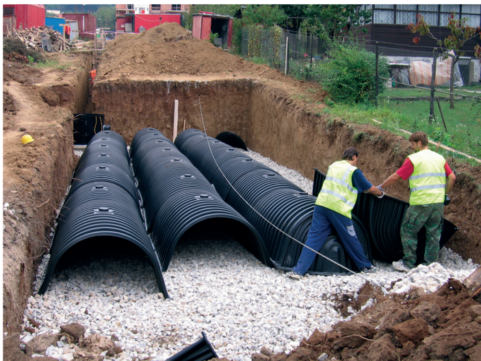
Obr. 6 Tunelový vsakovací objekt [2]
