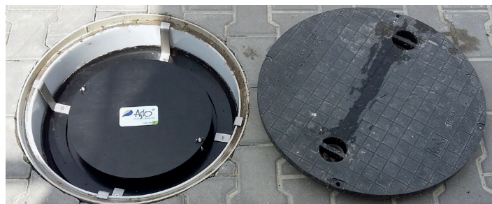
Obrázek 5. Příklad sorpčního filtru AS-OREO v kanalizační šachtě
