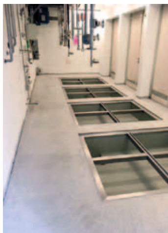
Foto po betonáží
