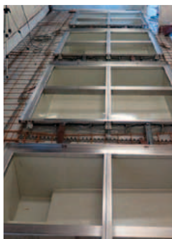
Foto před betonáží
