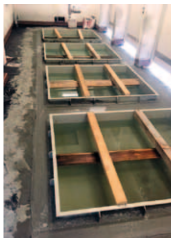
Příprava k betonáží
