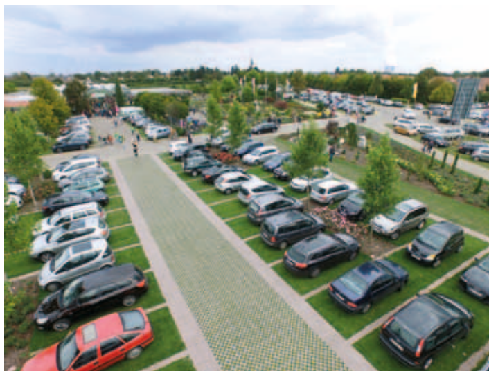
Příklad využití zasakovacích roštů pro zpevněné propustné povrchy AS-TTE ROŠT – parkoviště u obchodního centra
