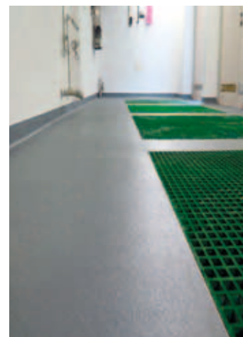
Foto po aplikaci průmyslové podlahy
