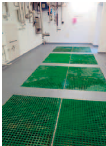
Foto po osazení úkapových roštů
