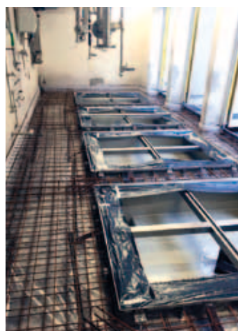
Foto před betonáží
