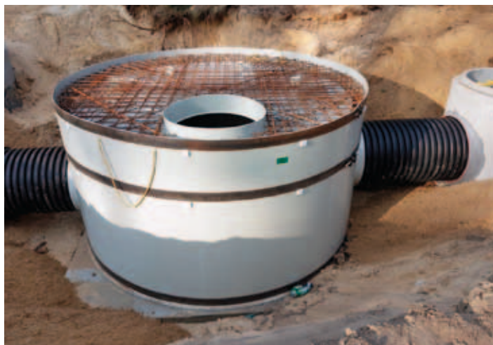
Instalace AS-BALOK K800 před zahájením betonáže po připojení nápojních potrubí
