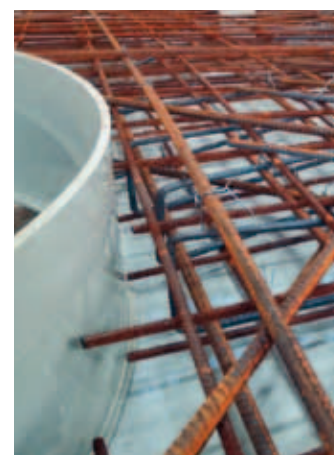
Robustní armování stropu odlehčovací komory
