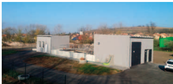
Čistírna odpadních vod – ČOV Přitluky (870 EO)
