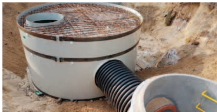
Pohled na AS-BALOK K800 s nainstalovanými dočasnými pásovými výztuhami vnějšího pláště
