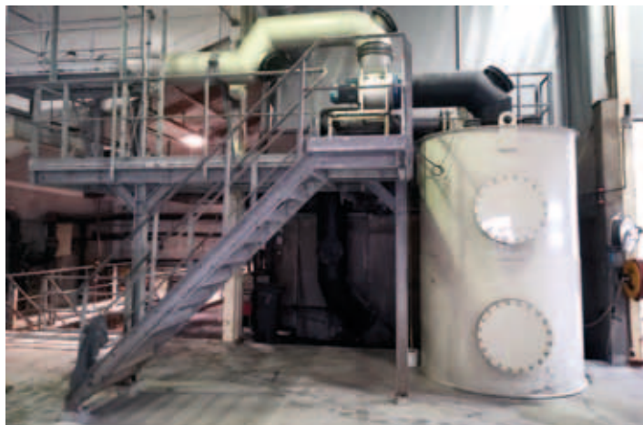
Nadzemní válcový filtr pro čištění vzduchu
