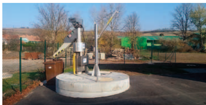
Objekt čerpací stanice
