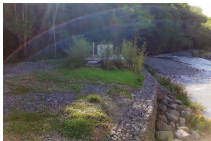
Pohled na ČOV od řeky
