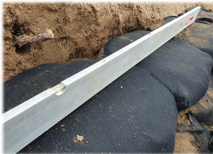
Kontrola rovinnosti vrchní řady
