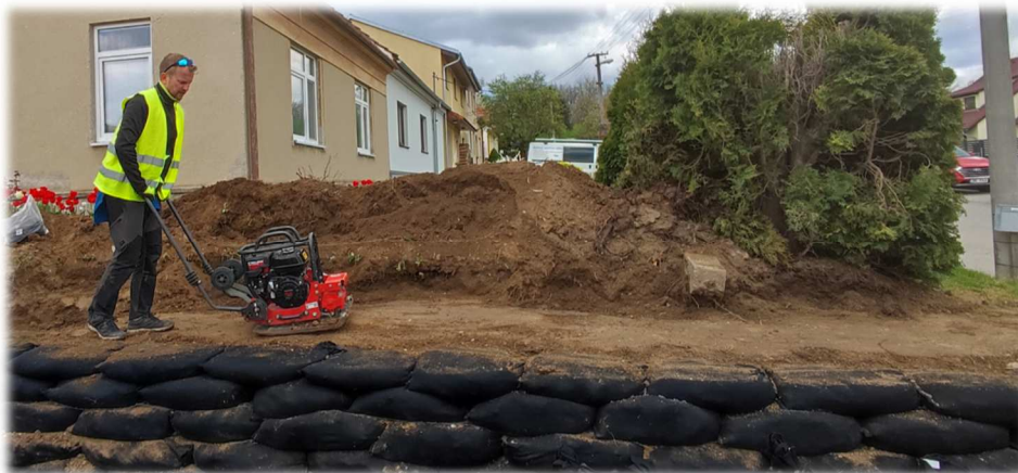
Hutnění vrstev pomocí vibrační desky
