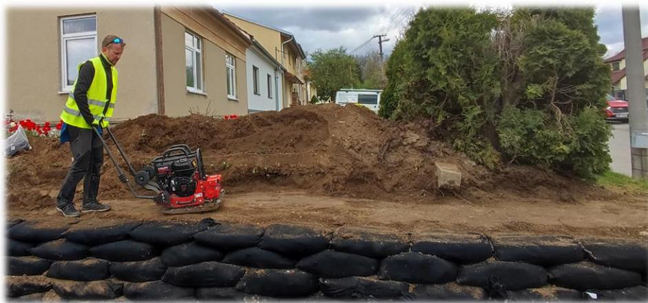
*Hutnění vrstev pomocí vibrační desky*
