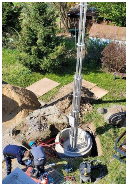
Obr. 14 Vlevo: Základová patka s chemickými kotvami, Vpravo: ukázka osazení konstrukce s jeřábem
