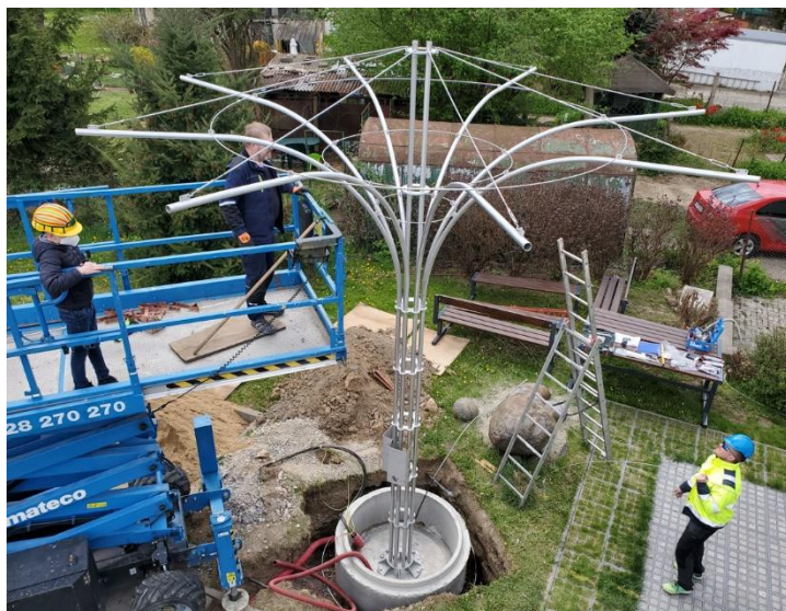
Obr. 18 Vlevo: Instalace prstencových prutů, Vpravo: hotová konstrukce
