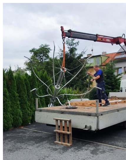
Obr. 15 Vlevo: Základová patka s konstrukcí kmene, Vpravo: Osazení konstrukce kmene pomocí autojeřábu
