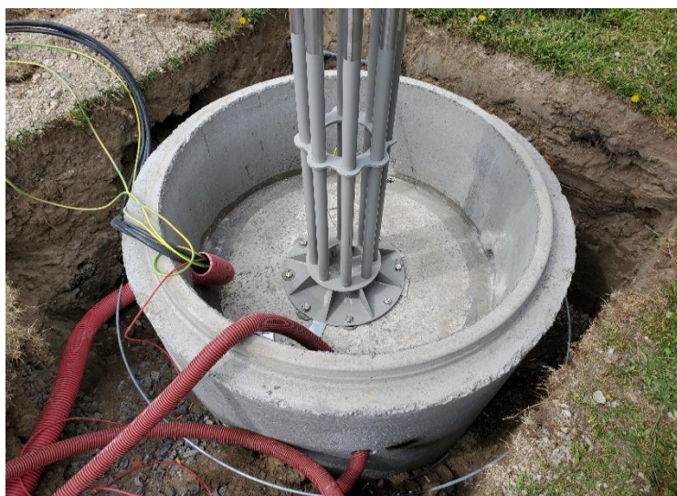
Obr. 15 Vlevo: Základová patka s konstrukcí kmene, Vpravo: Osazení konstrukce kmene pomocí autojeřábu
