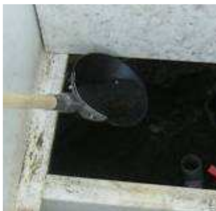
přelití vyflotovaného kalu do kalového prostoru
