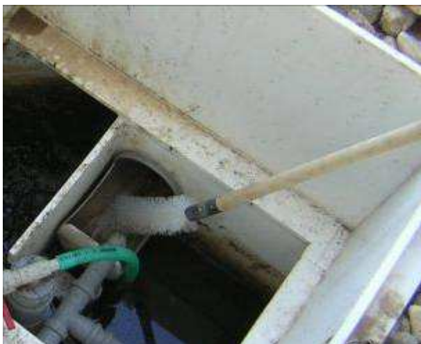
čištění odtokového žlabu
