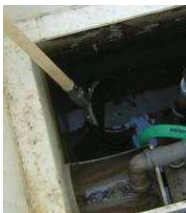
vybrání vyflotovaného kalu z dosazovacího prostoru
