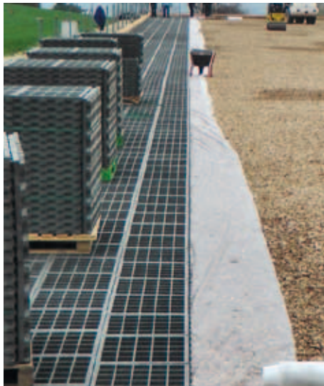
Pokládka systému AS-TTE®
