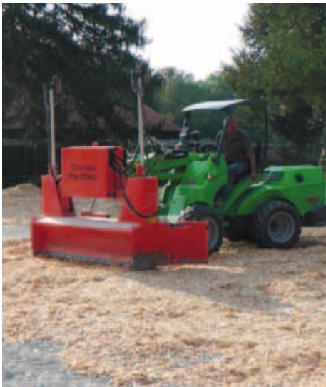
Pokládka elastické vrstvy
