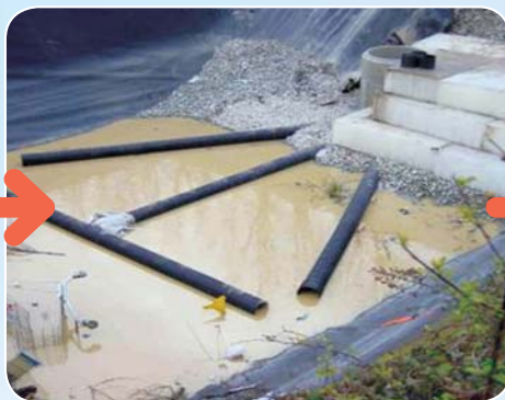
Vložení plastových akumulčních systémů
