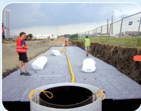
Montáž odvětrávacího potrubí
