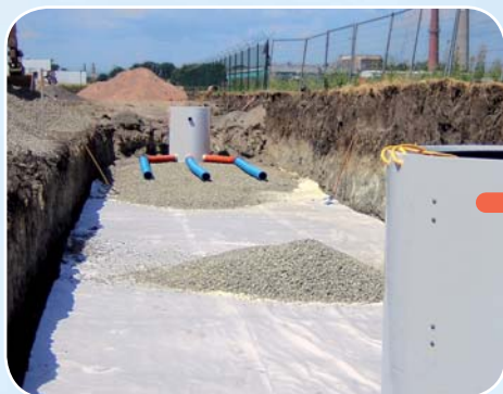
Zahájení prací – osazení šachet a geotextilie
