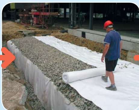
Pokládka ochranné geotextilie
