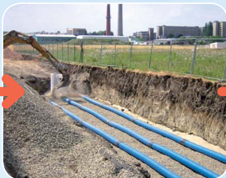
Propojení šachet drenážním potrubím a štěrkováním
