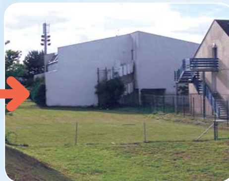
Výsledný efekt! Podzemní akumulční prostor. Krásné zákoutí areálu
