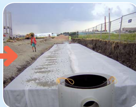
Kompletní objekt před zasypáním
